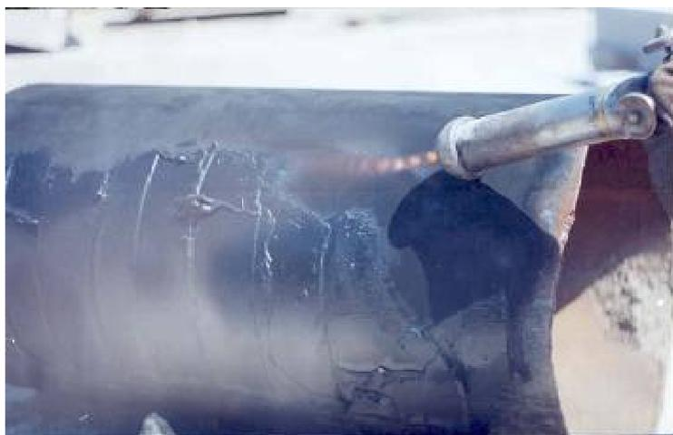
Рис. 1. Положение реактивной газовой горелки по отношению к обрабатываемой поверхности трубы
